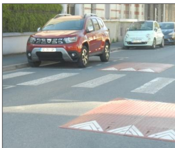
Coussins de Rollin à remplacer
